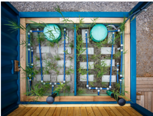
Humedal construido modular (@Julian Rettig 2020)
